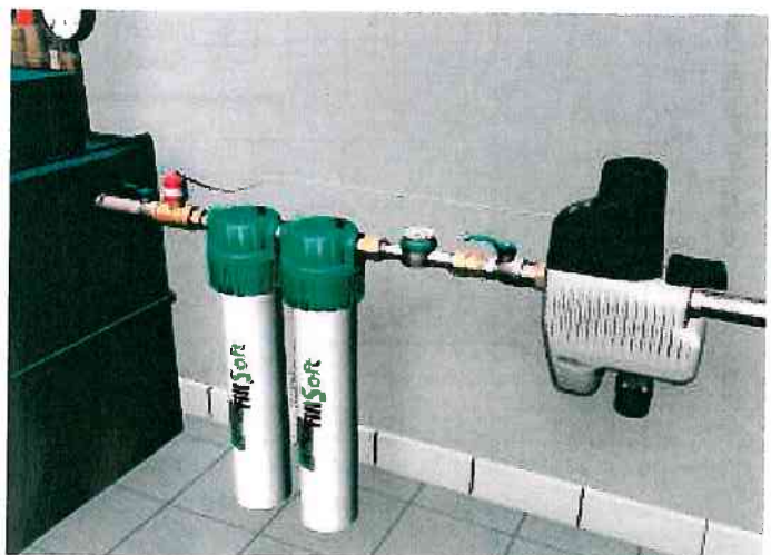
Bild 2 · fillsoft II – die neue Enthärtungspatrone.
